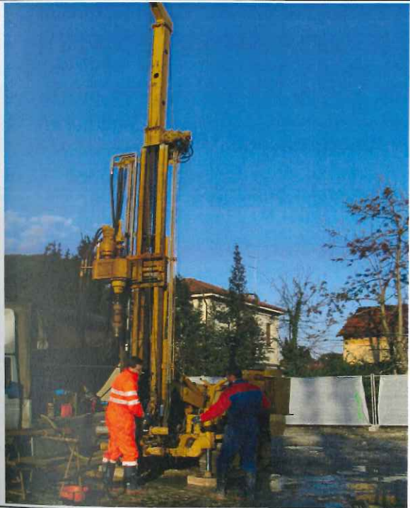
Foto 3: posizionamento sondaggio GH1
