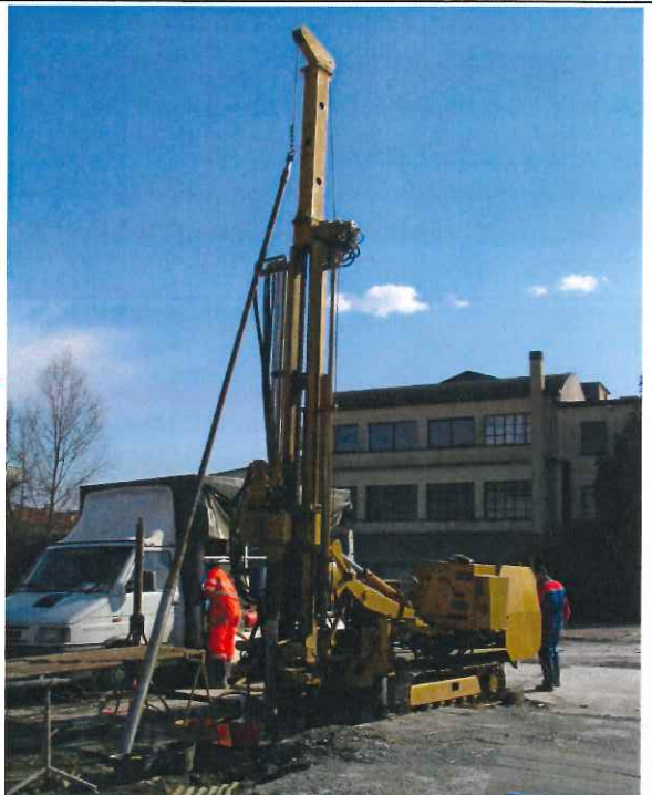
Foto 4: posizionamento sondaggio GH2
