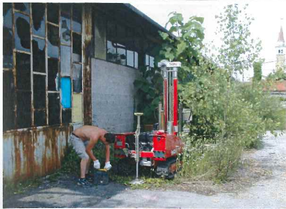
Punto di esecuzione PPS12
